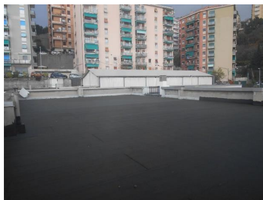
Figura 8.3 - Particolare della copertura
