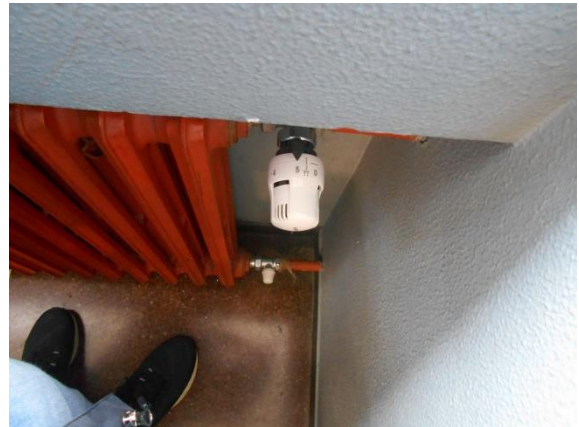
Figura 4.14 – Particolare di un radiatore in ghisa con valvola termostatica
