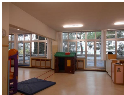
Figura 4.4 – Particolare dei serramenti
