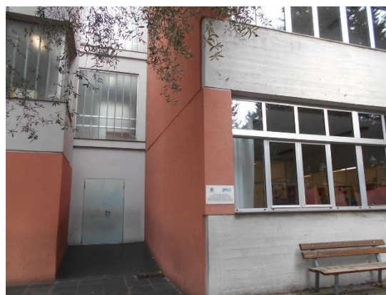
Figura 8.1 - Particolare di una parete esterna
