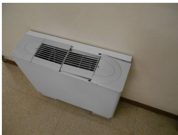
Figura 4.9 – Particolare di un ventilconvettore
