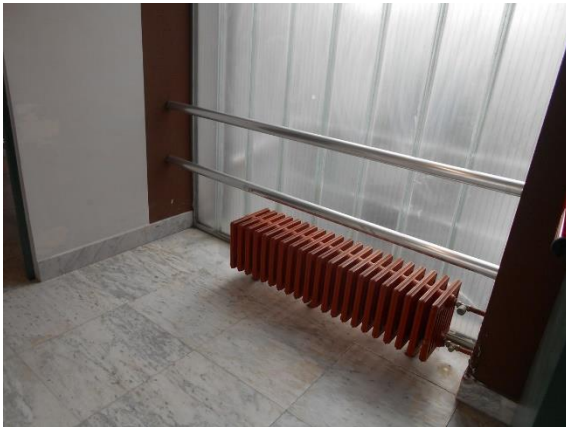
Figura 4.13 – Particolare di un radiatore in ghisa con valvola on-off
