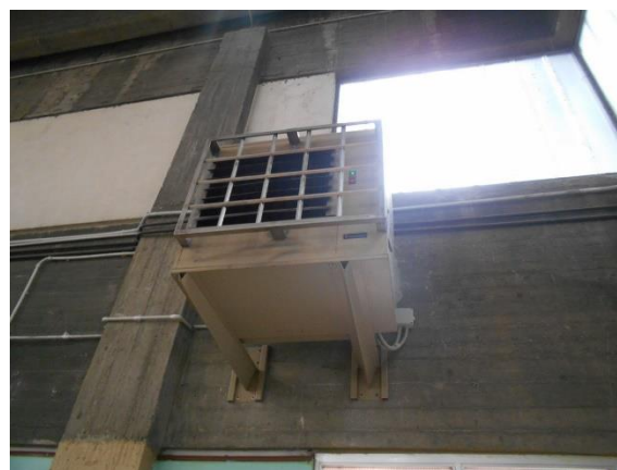
Figura 4.10 – Particolare di un aerotermo ad acqua
